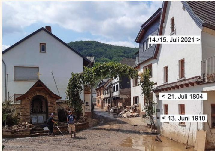
Foto B. Schreiner 22.07.2021: Dernau Hauptstr. Altes Haus mit den Wasserständen von 1804, 1910 und dem Wasserstand am 14./15. Juli 2021. Gem. SGD Nord am Pegel Altenahr eine Abflussmenge von 854 m<sup>3</sup>/sek (zum Vergleich 2016: 236 m<sup>3</sup>/sek).
