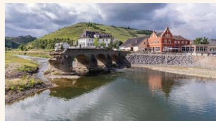
Foto B. Schreiner (2021): Durch die Ahrflut teilw. zerstörte, älteste Steinbrücke des Ahrtals in Rech
